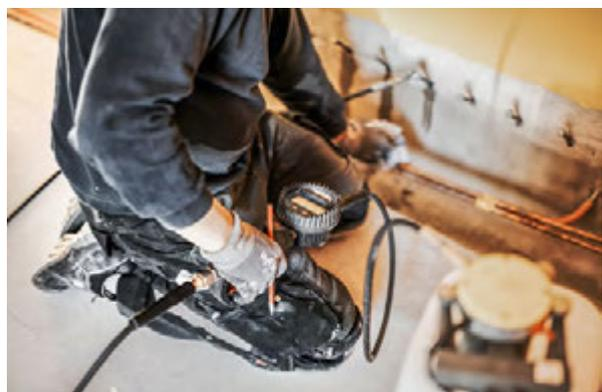
Die Abbildungen zeigen den Ablauf der **Erstellung einer nachträglichen Horizontalsperre** durch einen zertifizierten Fachbetrieb.
