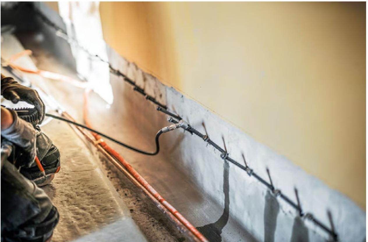
Niederdruckinjektion des Produktes mittels Verpresslanzen.
